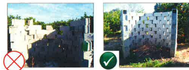
Foto 2. Construcción formada por bloques con y sin cemento de unión.
